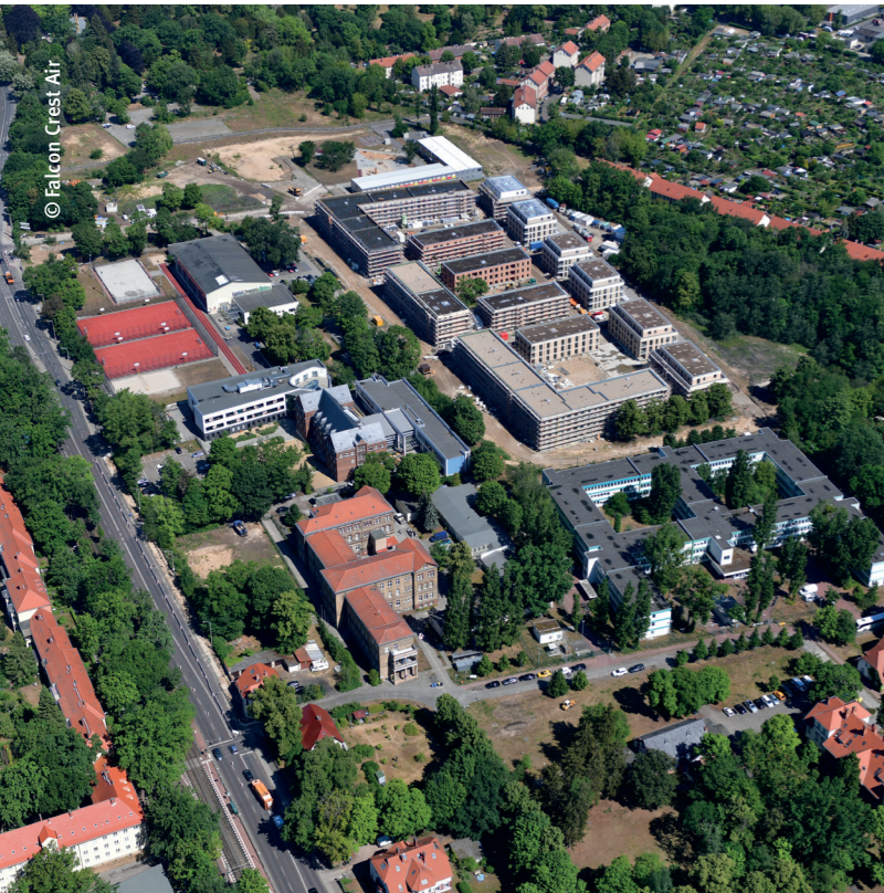
Auf dem Gelände des ehemaligen Tramdepots an der Heinrich-Mann-Allee entsteht ein neues Quartier.
